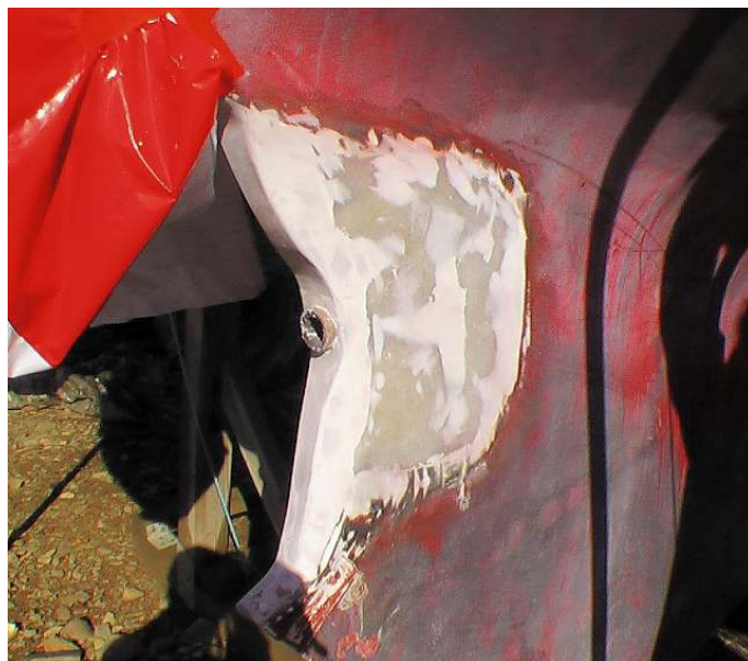
Nya lagerhylsan fastplastad. Har spacklat ut en tunnare avslutning av skrovet i propelleruttaget
