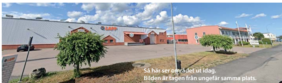
ACVA BÅT AB låg på Kungshagsvägen 7. Byggnaden är numera riven.
